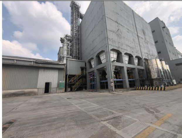
厂区内部-筒仓群
